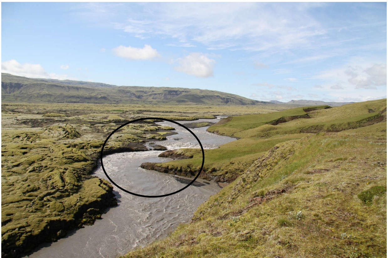
Mynd 3.8 Horft til norðurs að fyrirhuguðu brúarstæði (innan hrings).
